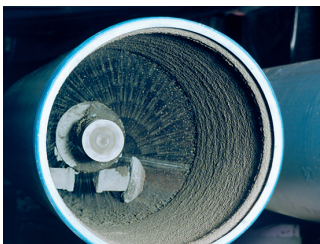
Auskleidung durch das Anspritzverfahren
