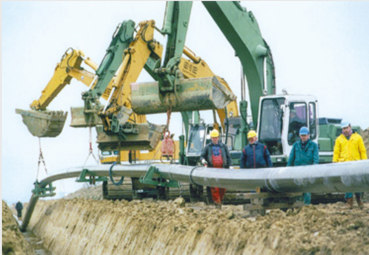
Bild 3: Biegeradien bei der Verlegung verschweißter Rohrstränge
