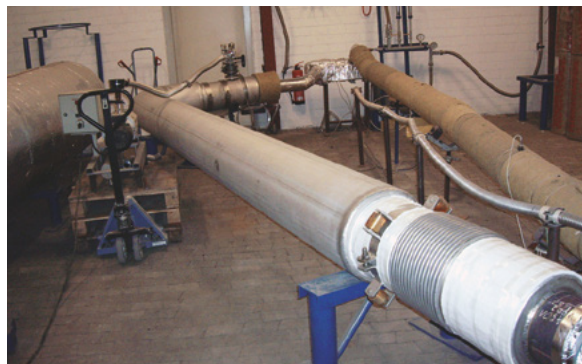
Bild 3: FW-Kammer-Rohr während Montage
